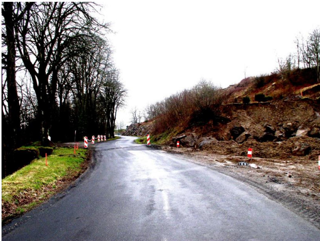
Illustration 5 - Aperçu du talus amont de la RD 990 en avril 2008 (photo BRGM)
