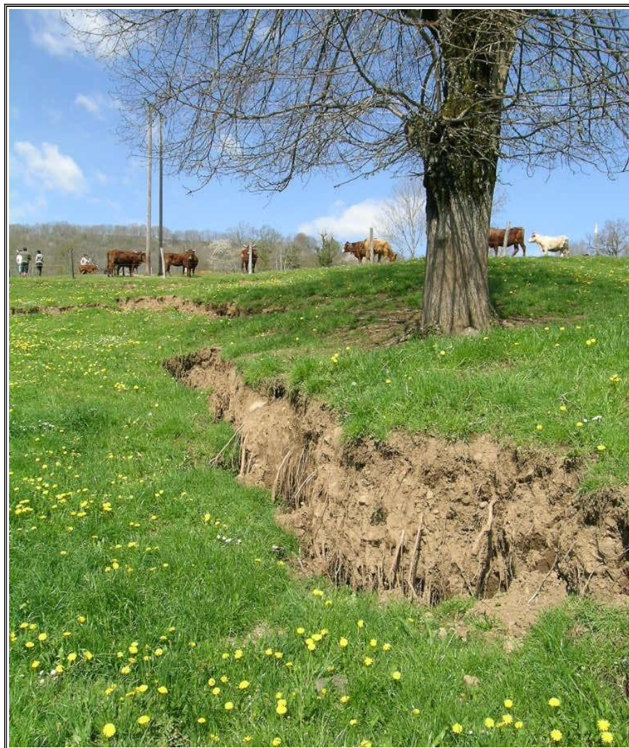
Illustration 5: Surface de rupture (glissement du pont du Goul) (source DLCF - prise de vue mai 2008)
